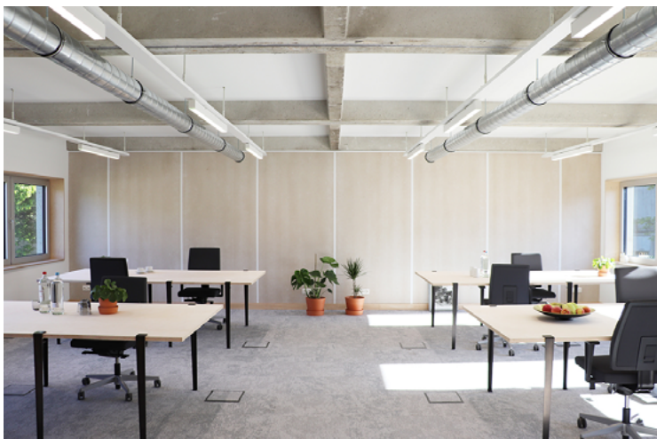
Dans le Circular Retrofit Lab, les techniques ont été exécutées en partie en apparent et en partie sous un faux-plancher technique. © Ineke Tavernier
