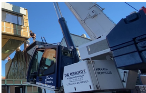
Deux modules Mobble ont été assemblés en usine et parachevés sur le site même © Inhout
