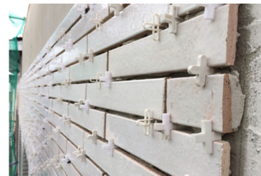
Dans le projet Dethy, des lots de tuiles rejetés ont été utilisés pour la finition des façades © Lionel Bousquet
