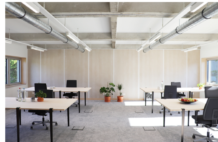
Dans le Circular Retrofit Lab, les murs intérieurs ont été surdimensionnés et des clapets coupe-feu ont été installés sur les conduits de ventilation où un mur coupe-feu sera ultérieurement installé. © Inneke Tavernier
