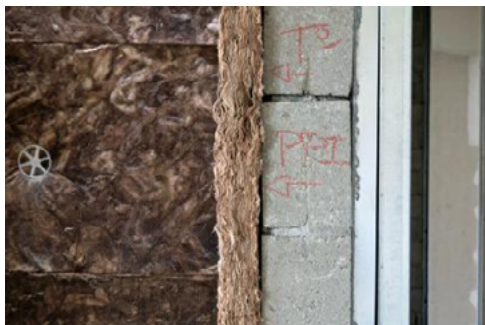
Des matériaux d'isolation de réemploi ont été utilisés dans le projet Ambassade © Jonathan Ortegat
