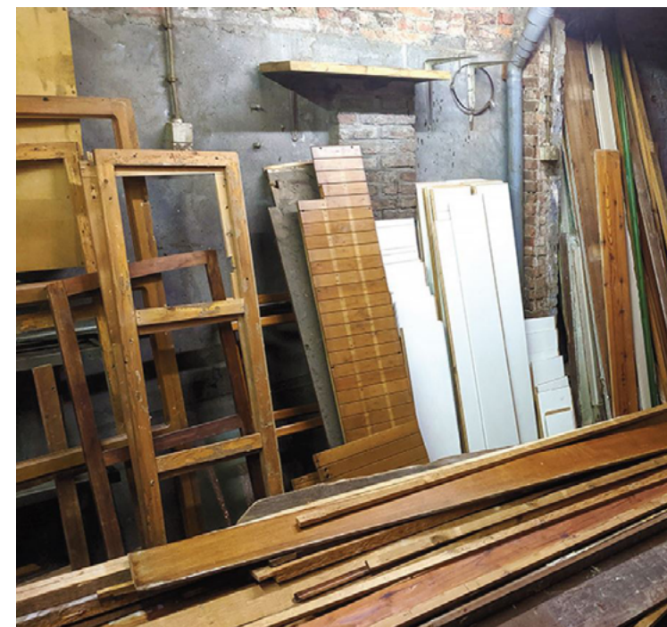
L'aménagement existant du projet Passiefrijhuis a été démolie de manière sélective. © Christophe Lambrechts
