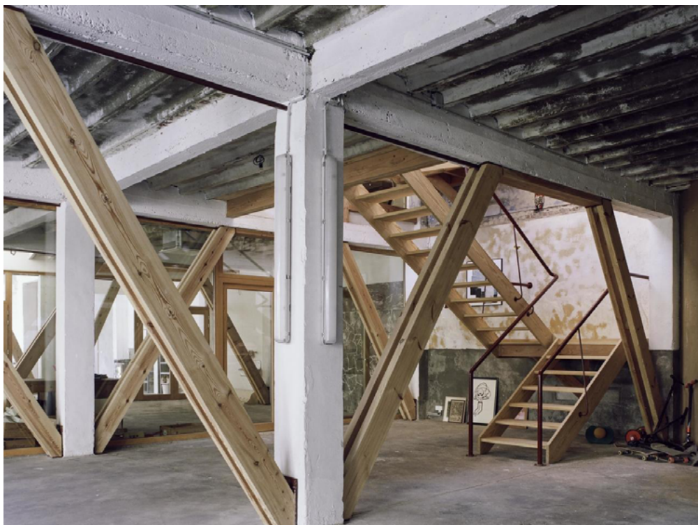
La réaffectation d'un entrepôt pour y installer la maison « Verbiest » a nécessité le renforcement de la structure. © Séverin Malaud
