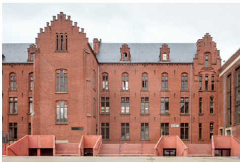
Lors de la rénovation du Virga Jesse College, deux nouveaux volumes ont été ajoutés : une entrée et un nouveau socle qui, à moitié enterré, abrite un nouveau bloc sanitaire et une salle polyvalente. ©Stijn Bollaert
