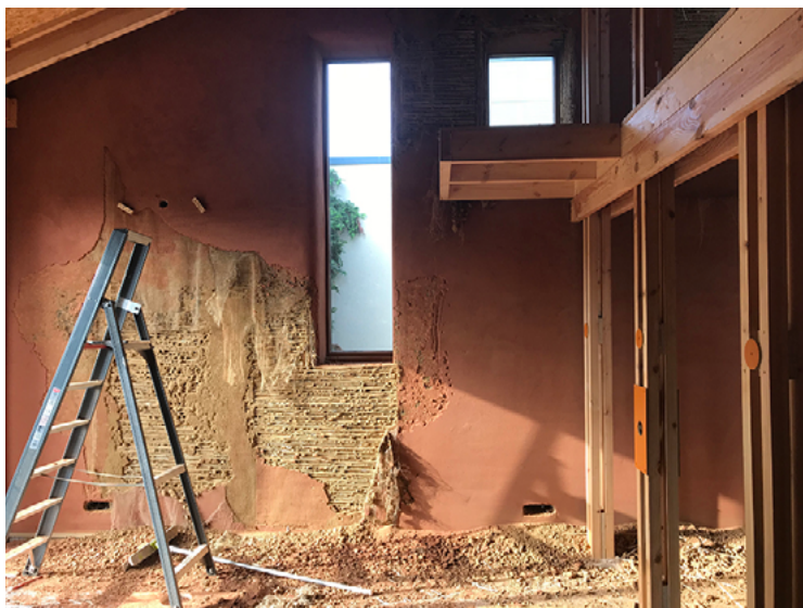
Dans le projet BRIC, l'enduit d'argile a été enlevé et réutilisé en ajoutant de l'eau – Source : bamb2020.eu
