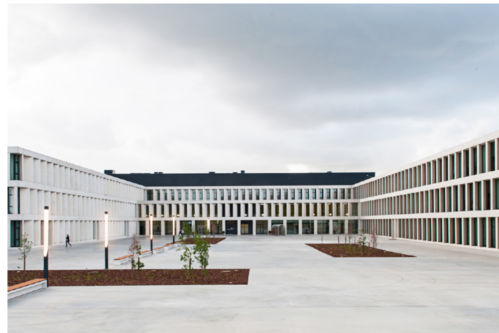
L'hôpital AZ Groeninge a été conçu pour être construit en plusieurs phases. Ces extensions sont possibles grâce à des éléments de façade amovibles. Des éléments de toiture amovibles ont également été prévus pour remplacer les grandes installations à l'avenir ou pour introduire de grands appareils. ©Kris Van de Vijver
