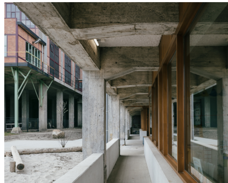
La réaffectation des bains de l'ancien site minier de Beringen en école KABO a utilisé le principe « box-in-box » afin de préserver la façade d'origine. © Stijn Bollaert
