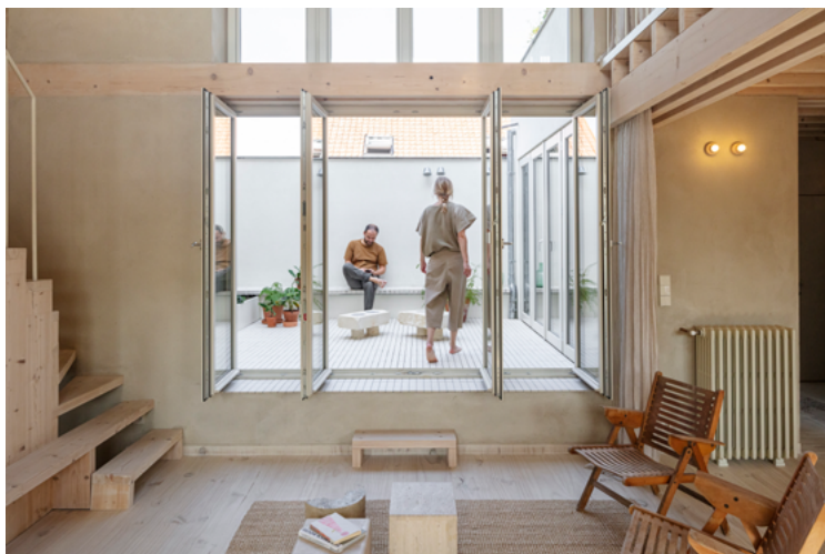
Seul un nombre limité de matériaux a été utilisé pour la rehausse de la maison KAPER. On retrouve par exemple le bois comme matériau structurel, mais aussi pour la fabrication de l'escalier et du mobilier. © Tim Van de Velde
