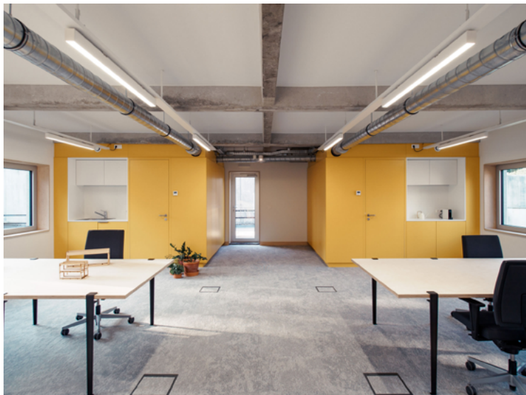
Dans le Circular Retrofit Lab, les techniques et les fonctions humides ont été regroupées dans un module BAO. © KADERSTUDIO
