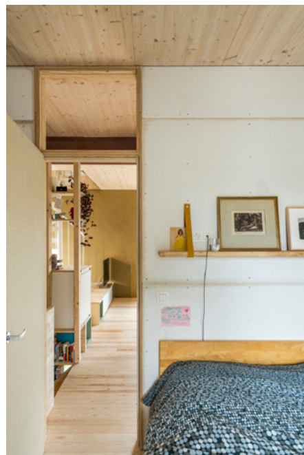
Dans la maison individuelle « Adriaan » à Mariakerke, les vis des plaques de plâtre ont été laissées apparentes, ce qui permet de les démonter facilement à l'avenir. © Luc Roymans
