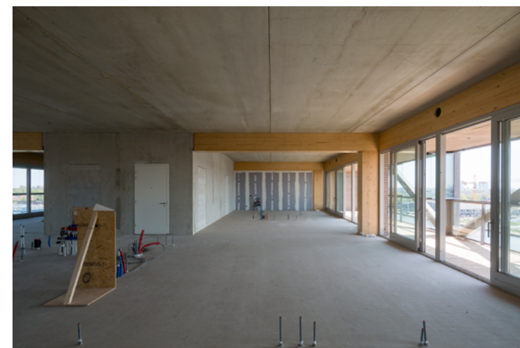
Dans le cadre du projet PATCH22, les planchers ont été dimensionnés pour des charges de 4 kN/m 2 au lieu des 2 kN/m 2 habituels. Cela permet aux étages de 4 m de haut d'accueillir d'autres fonctions par la suite © Luuk Kramer
